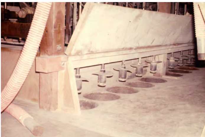
④ 閉鎖系の装置が導入された工場内の様子
